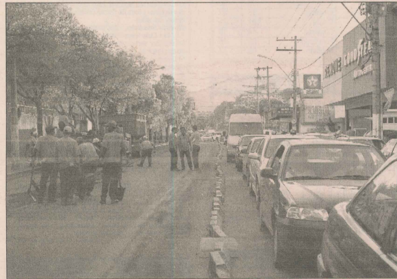
Trânsito parcialmente interdito na avenida para as obras
