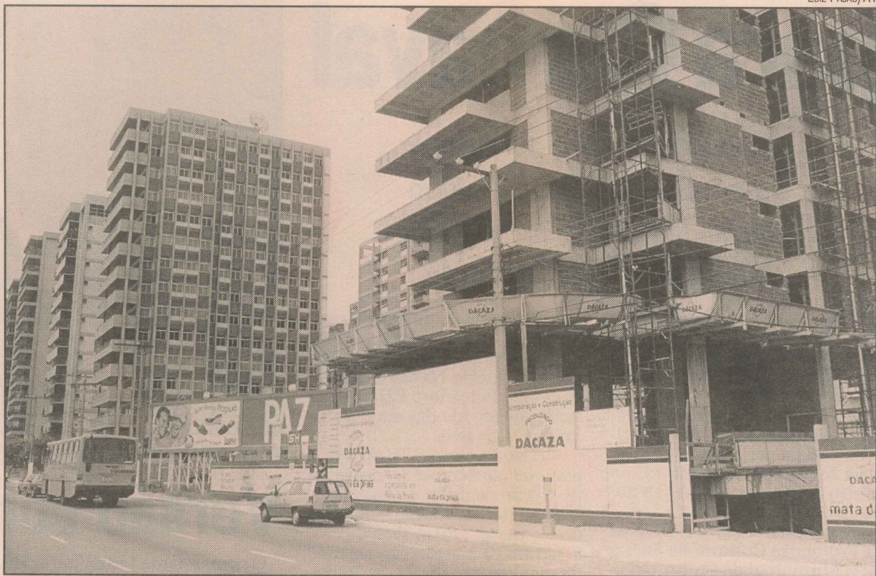
Na região da Mata da Praia, é comum encontrar edifícios em construção
