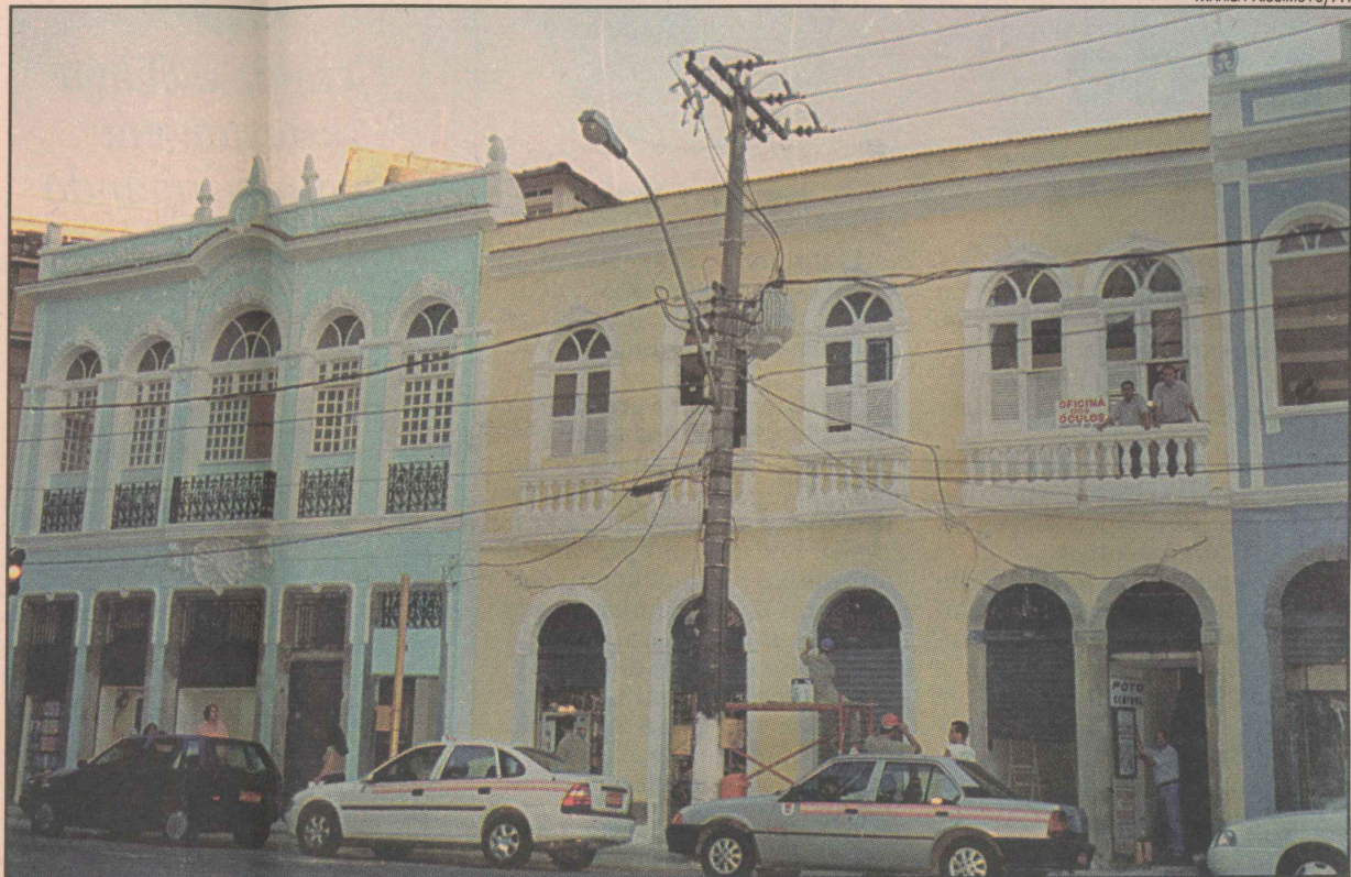
Fachadas dos prédios são recuperadas com o objetivo de revitalizar o Centro
