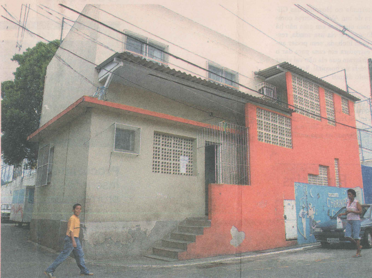
PROBLEMAS. No alto, encosta que corre o risco de deslizar e logo acima, posto de saúde improvisado: moradores querem que as duas situações sejam resolvidas. FOTO: CARLOS ALBERTO DA SILVA
