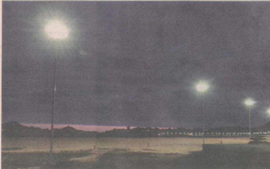
O projeto inicial foi alterado; foram instalados mais postes e luminárias
