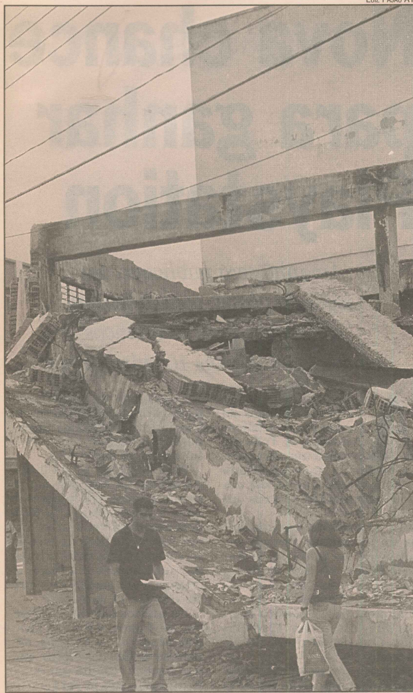
A loja Arapuã foi destruída após incêndio no ano passado
