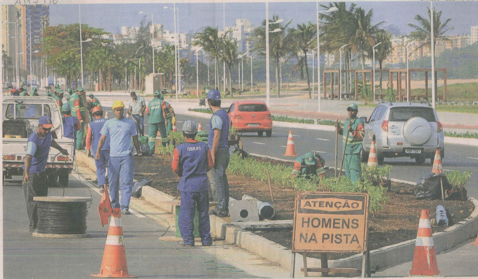
RITMO ACELERADO. Em média, 50 homens estão trabalhando na finalização da obra, que sofreu alterações na reta final, para dar mais espaço para estacionamento
