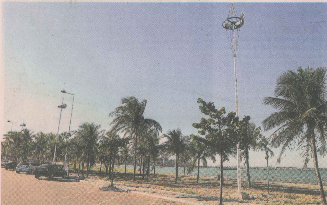
LUZ NA PRAIA. Ao todo, serão instalados 80 postes ao longo da orla. Desse total, seis já foram colocados no primeiro trecho da obra. A fiação será subterrânea, assim como as caixas de energia
