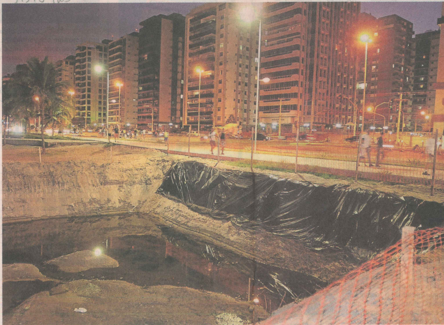
FUNDAÇÃO. Segundo Coser, obra dos quiosques está mais complicada do que se esperava, e por isso não há como garantir prazo
