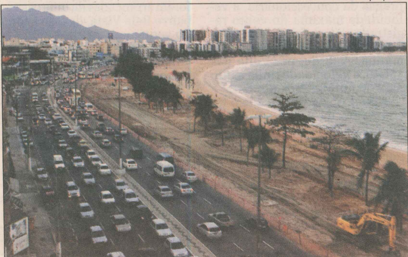
Avenida Dante Michelini, em Camburi: pista interditada
