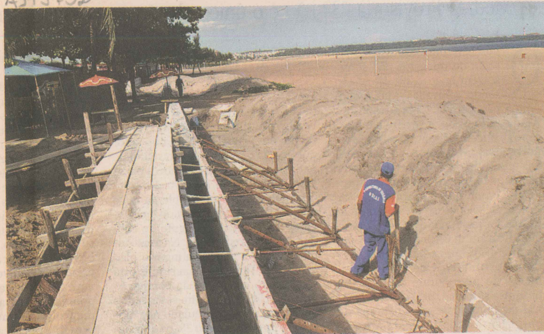
ACERTOS. Funcionários fazem apenas pequenos reparos na etapa já concluída. FOTOS: CARLOS ALBERTO DA SILVA
