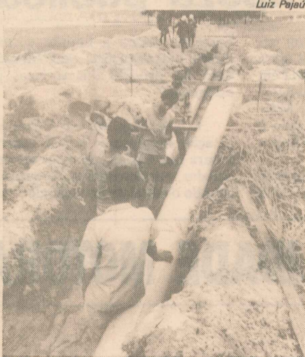
Águas pluviais têm obra de emergência
