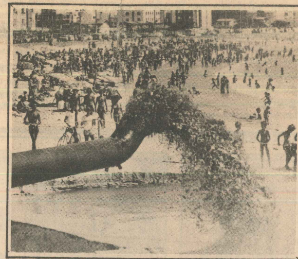
O aterro veio para corrigir velhos erros. Reconstruir uma praia destruída
