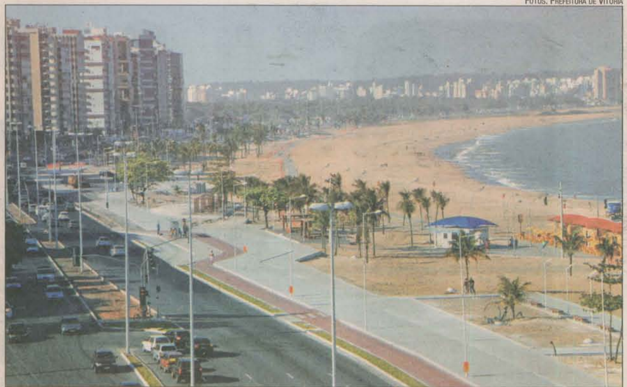
As obras em Camburi serão realizadas em sete etapas e devem ser concluídas no final de 2009
