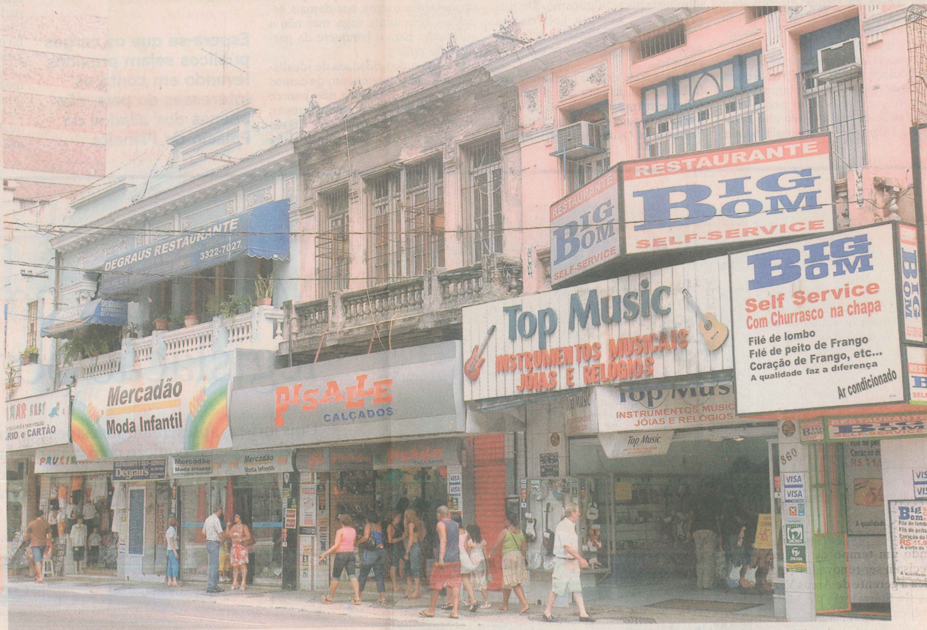
TESOURO ESCONDIDO. As fachadas de prédios antigos são cobertas por placas e letreiros de lojas. Muitos desses imóveis também estão mal conservados, o que tira ainda mais a beleza do Centro da Capital
