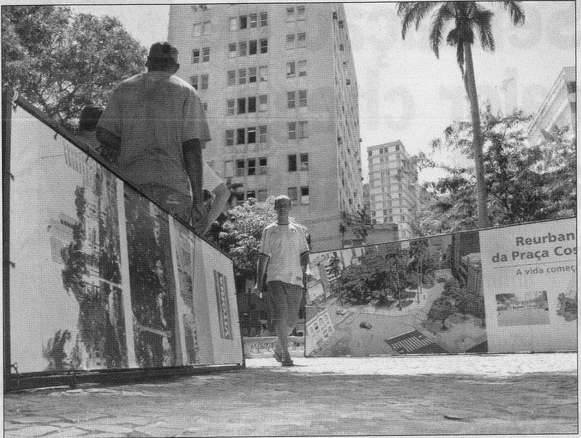
Outdoors instalados na praça mostram detalhes da obra e recuperação das calçadas
