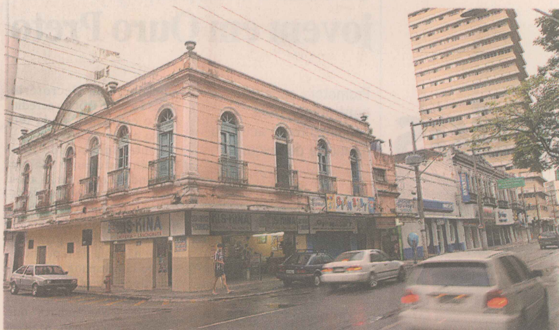
RISCO. Construções antigas estão sendo notificadas. CARLOS ABERTO DA SILVA
