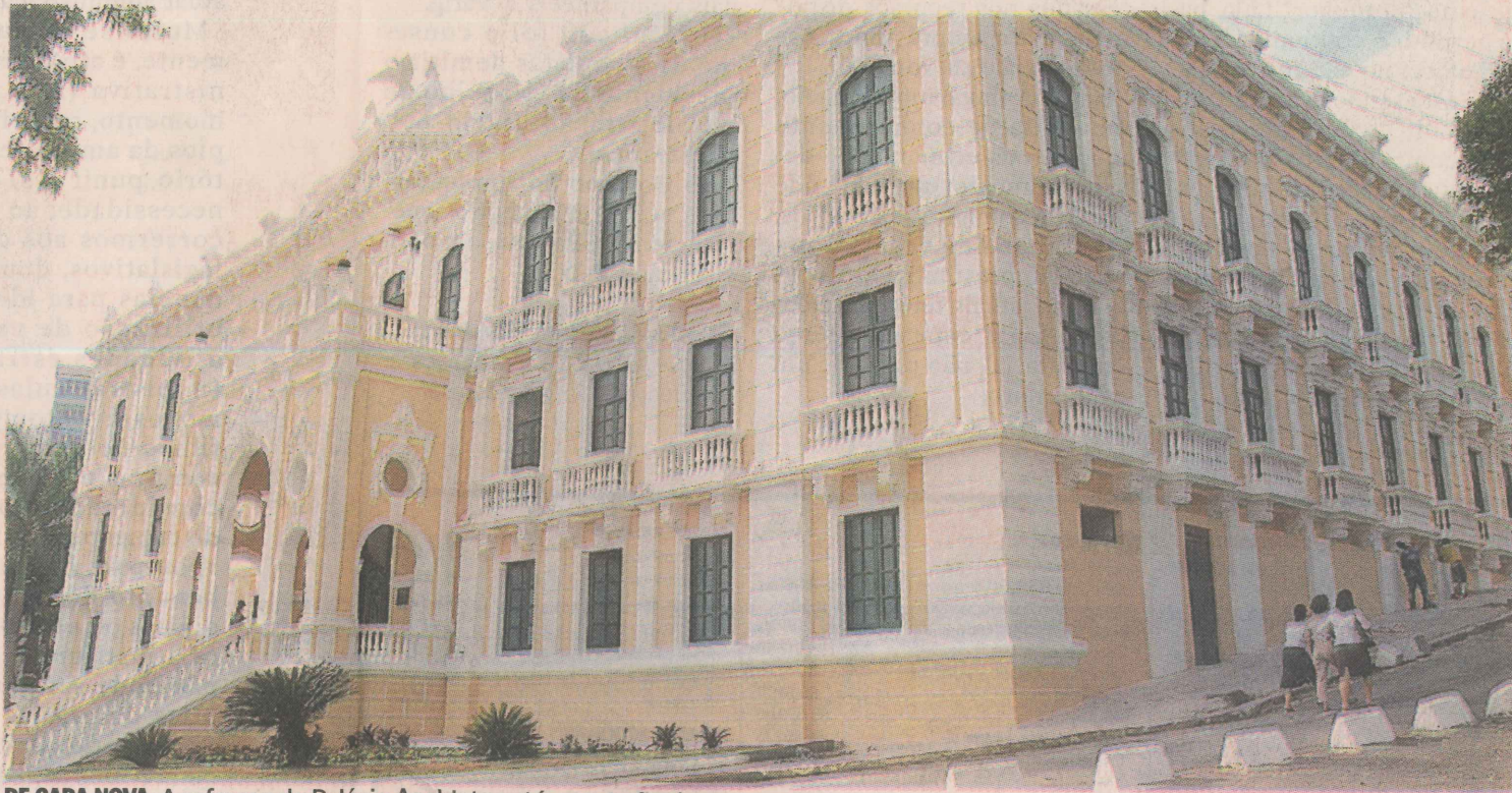
DE CARA NOVA. A reforma do Palácio Anchieta está na reta final. FOTO: CHICO GUEDES
