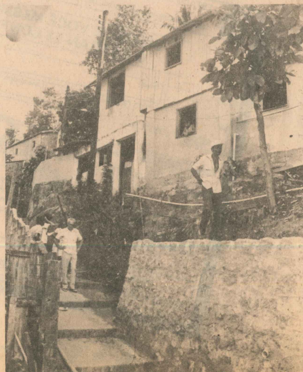
Nem todos têm proteção contra os deslizamentos
