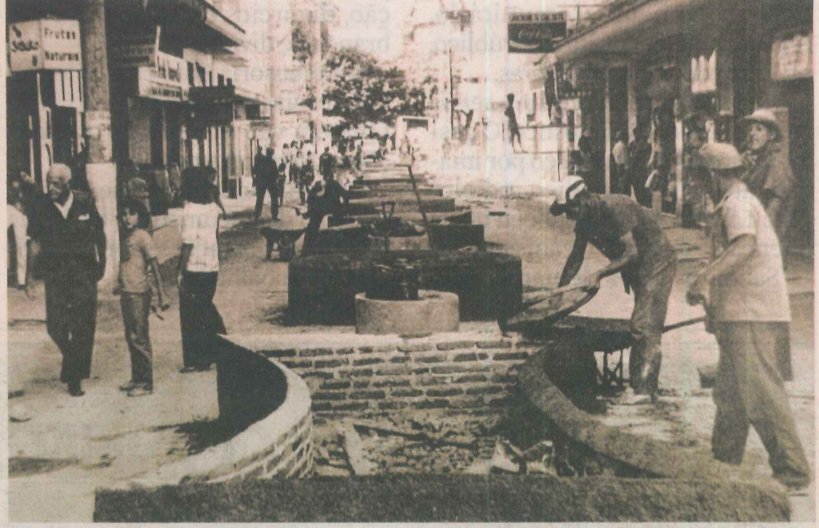
FOTO ANTIGA mostra a construção de canteiros na Rua Sete
