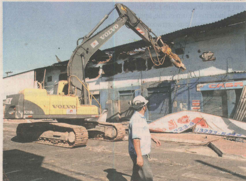
GALPÃO incendiado na Vila Rubim, Vitória, começou a ser demolido
