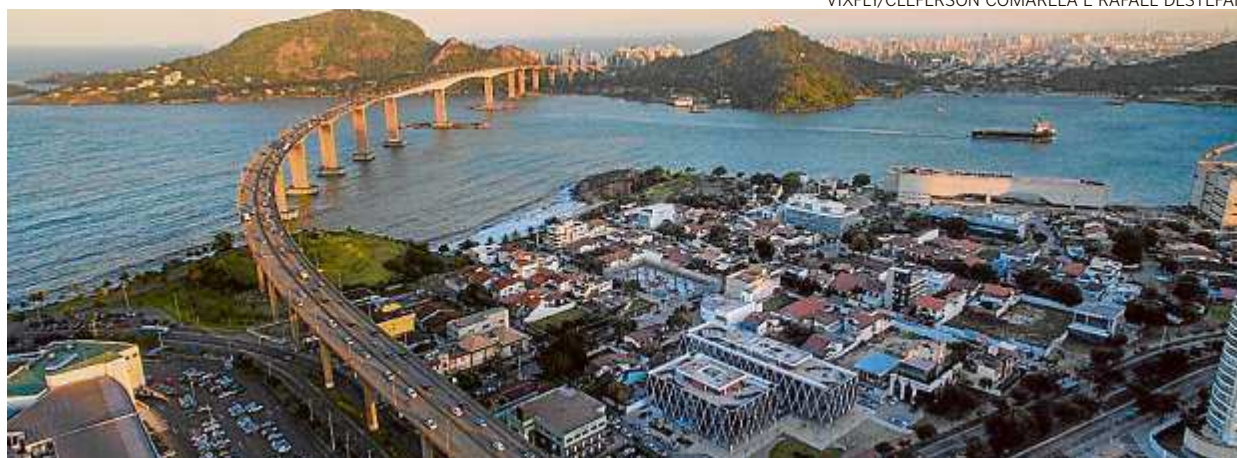
A Terceira Ponte tem 3.330 metros de extensão, 70 metros de altura e 61 pilares: cartão-postal da cidade
