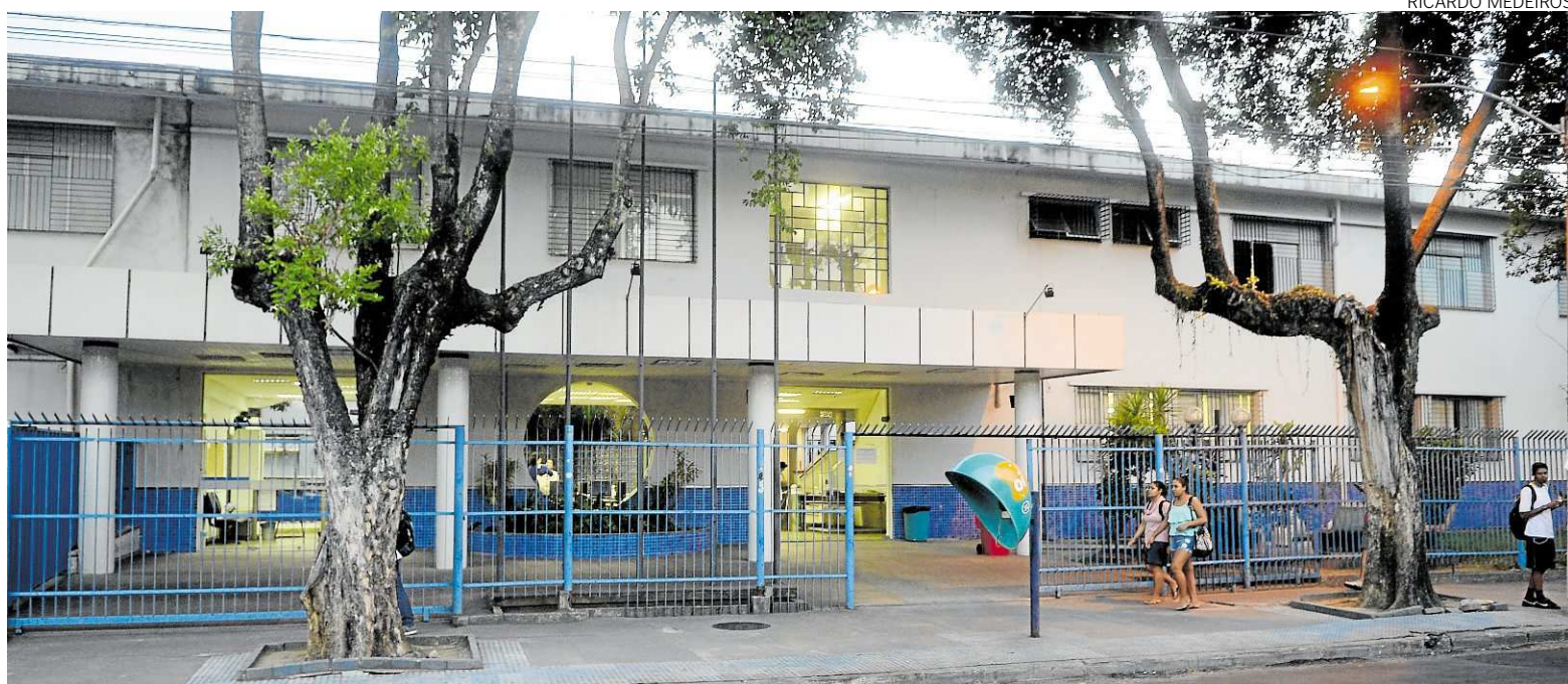
O campus de Vitória do Instituto Federal do Espírito Santo é um dos imóveis que serão notificados pela prefeitura para fazer a ligação
