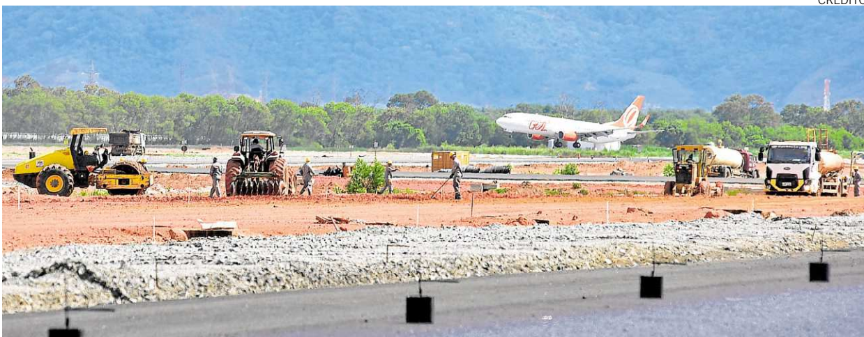
Pista do aeroporto de Vitória, com atualmente 1.750 metros, será ampliada e passará a ter 2.058
