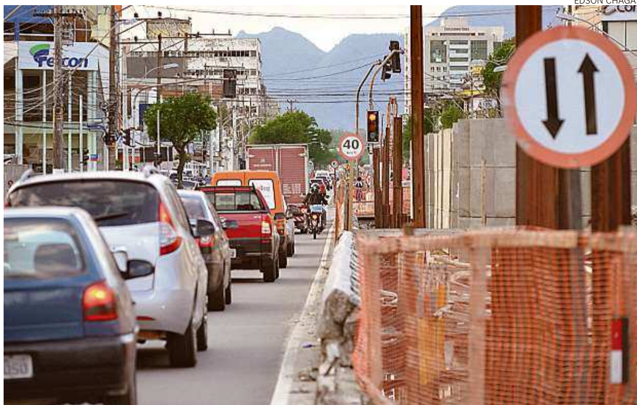
Obra na Avenida Leitão da Silva é uma das ações importantes para o início do novo sistema de transporte
