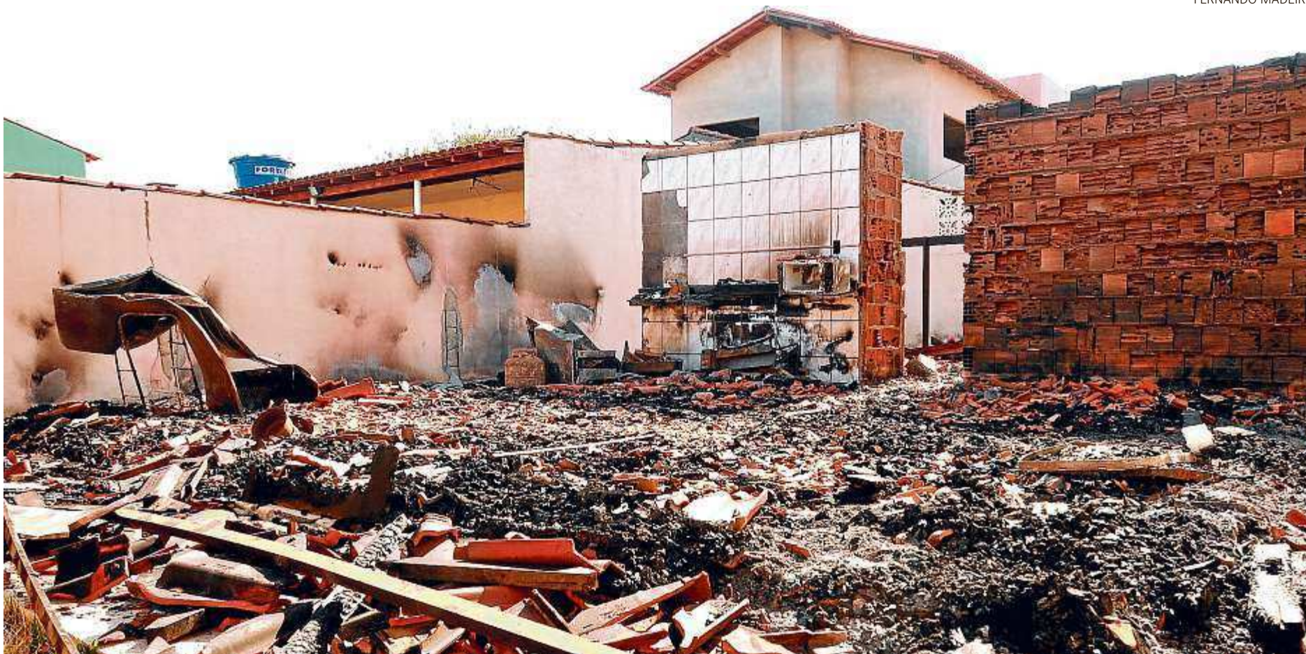
Seis residências na Barra do Sahy foram incendiadas e outras três ficaram totalmente destruídas; os proprietários ainda não conseguiram recuperar os imóveis
