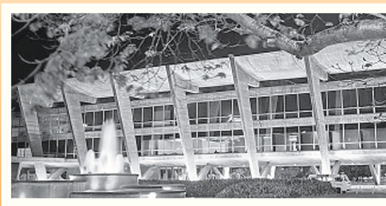
Museu de Arte Moderna do Rio de Janeiro (1954). Volume transparente elevado por pórtico de concreto.
