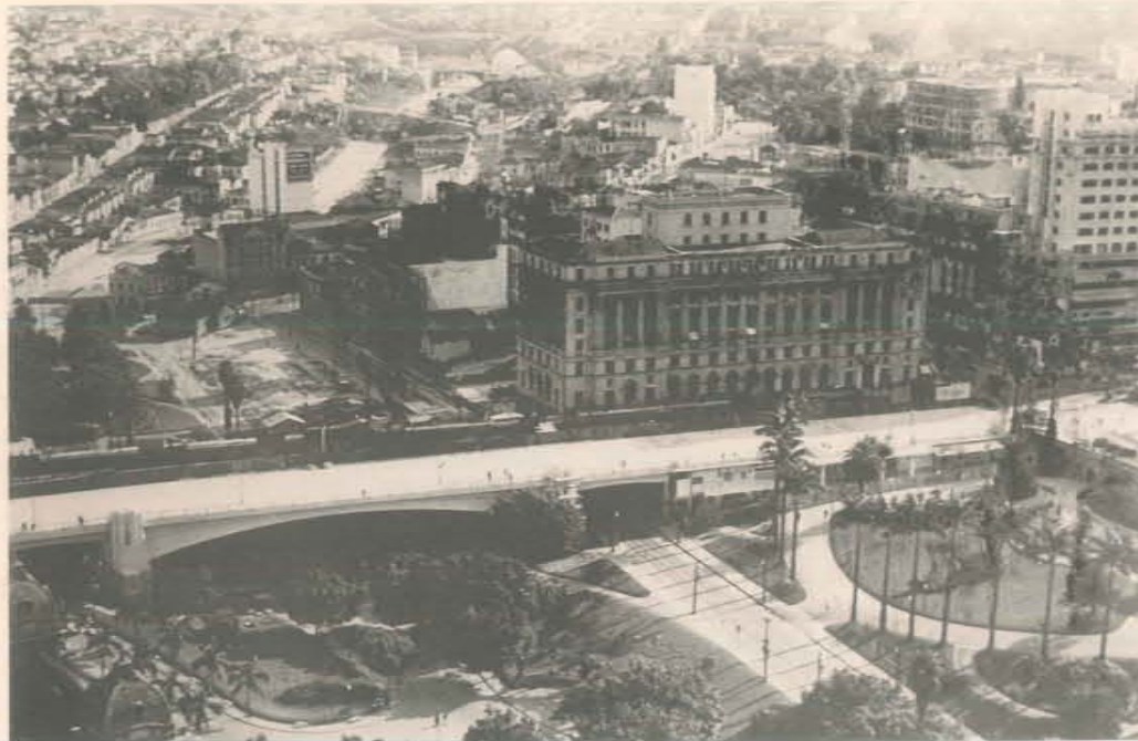
Parque do Anhangabaú e circunvizinhança (13/abril/1938) Vê-se, em primeiro plano, o parque do Anhangabaú, a praça Ramos de Azevedo, o viaduto do Chá, na fase terminal de sua construção, bem ao lado do antigo viaduto pouco antes de sua demolição, a rua Formosa e o prédio Alexandre Mackenzie (Light & Power). Mais ao fundo, a avenida 9 de Julho, os viadutos Major Quedinho e Martinho Prado e mais ao centro, a rua da Consolação.
